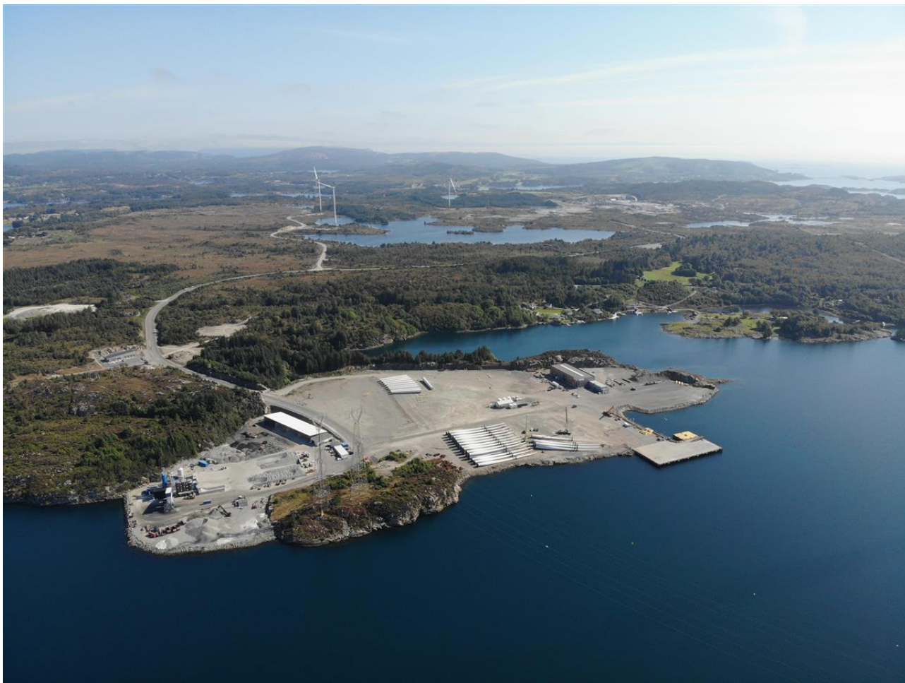
Haugaland næringspark, Tysvær kommune.
