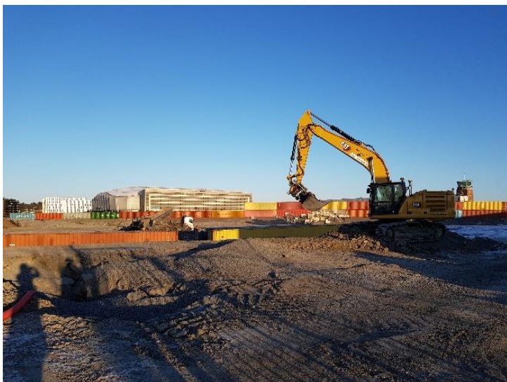
Figur 9: Gjenvinningsanlegg på Fornebu (foto: Tore Gulli, privat)
