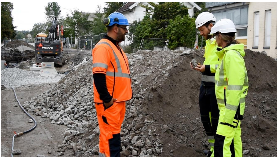
Figur 12: Bilde fra anleggsarbeidet i Storgata (foto: Norconsult).
