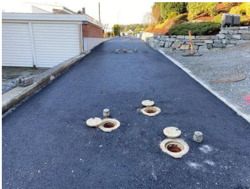
Figur 11: Deler av teststrekningen med setningsmålere (foto: SINTEF).
